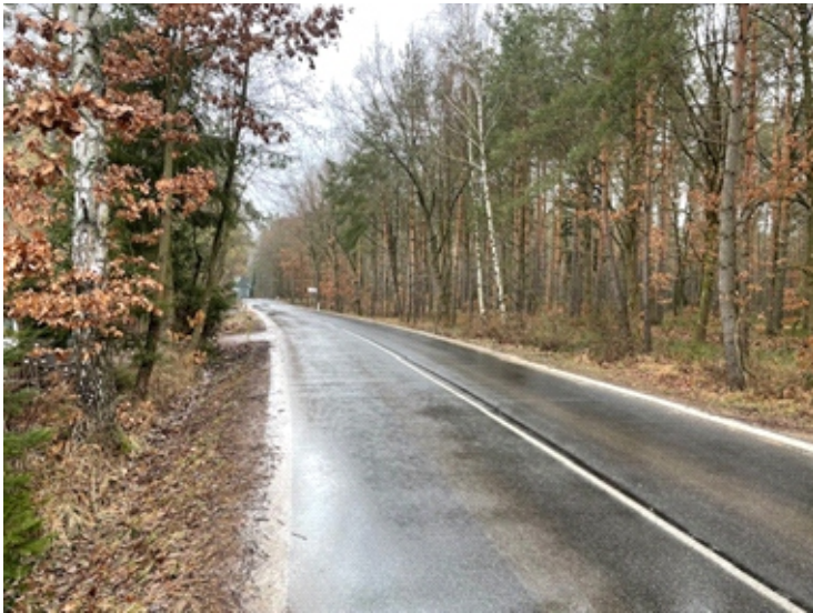
Pohled od stožáru na měřený úsek
