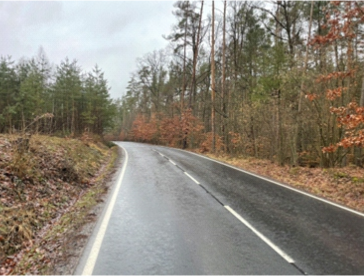
Pohled od stožáru na měřený úsek
