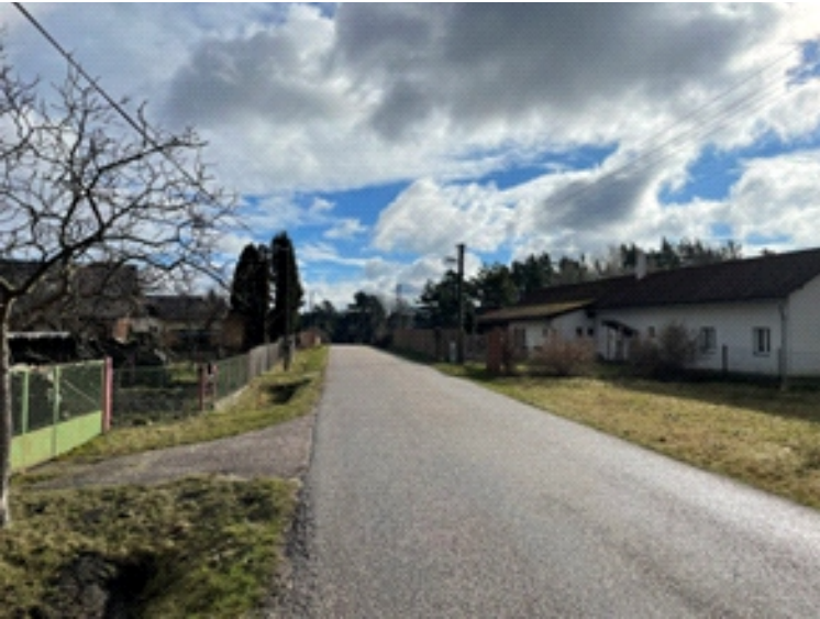
Pohled od stožáru na měřený úsek
