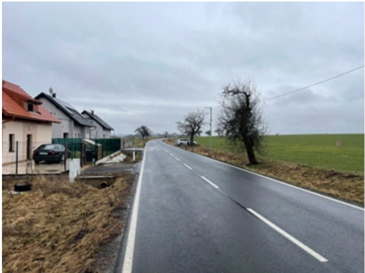
Pohled od stožáru na měřený úsek
