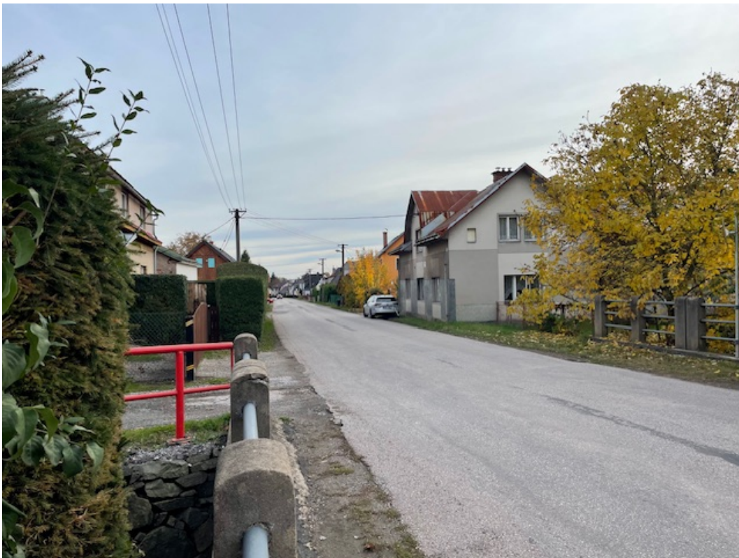
pohled od stožáru stacionárního měřiče na obec Dolní Branná (měřený úsek)
