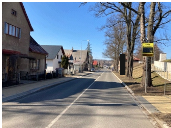
POHLED NA SLOUP VE SMĚRU NA CENTRUM
