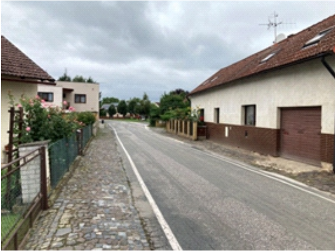
Pohled od stožáru na měřený úsek
