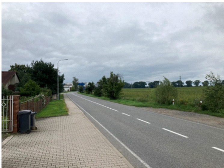
Pohled od stožáru na měřený úsek
