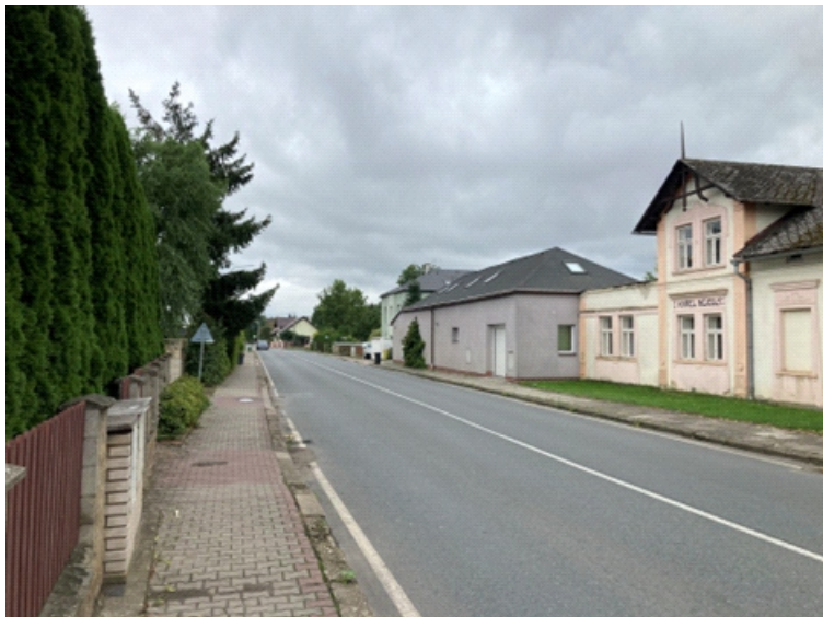
Pohled od stožáru na měřený úsek
