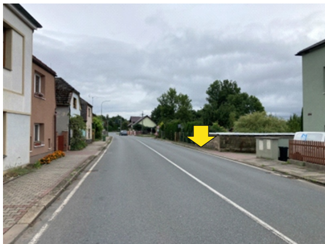
Chybí značení P2 - hlavní silnice před křižovatkou s místní komunikací.
