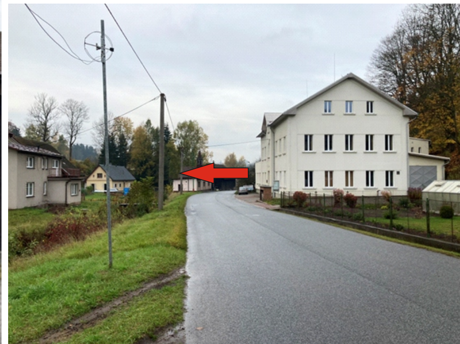
pohled na sloup ze směru jízdy po silnici II/286 od města Jilemnice
