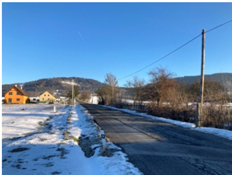
POHLED NA MĚŘENÝ ÚSEK
