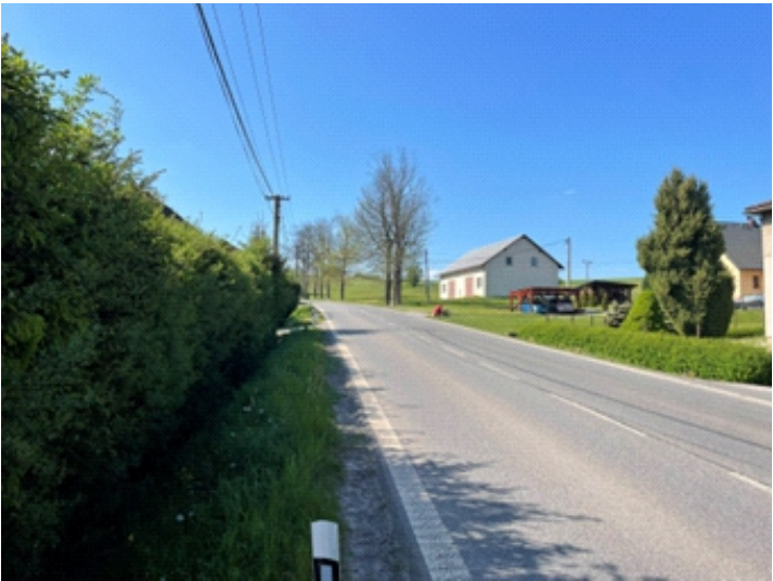
Pohled od stožáru na měřený úsek
