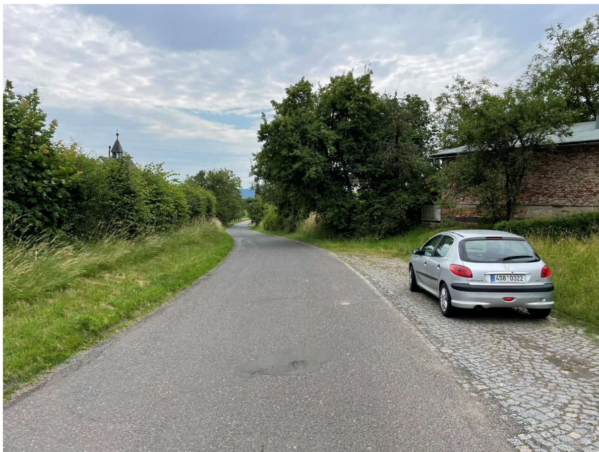
Obr.č.3 – Místo začátku novostavby chodníku u III/27911 naproti parkovišti obecního hřbitova
