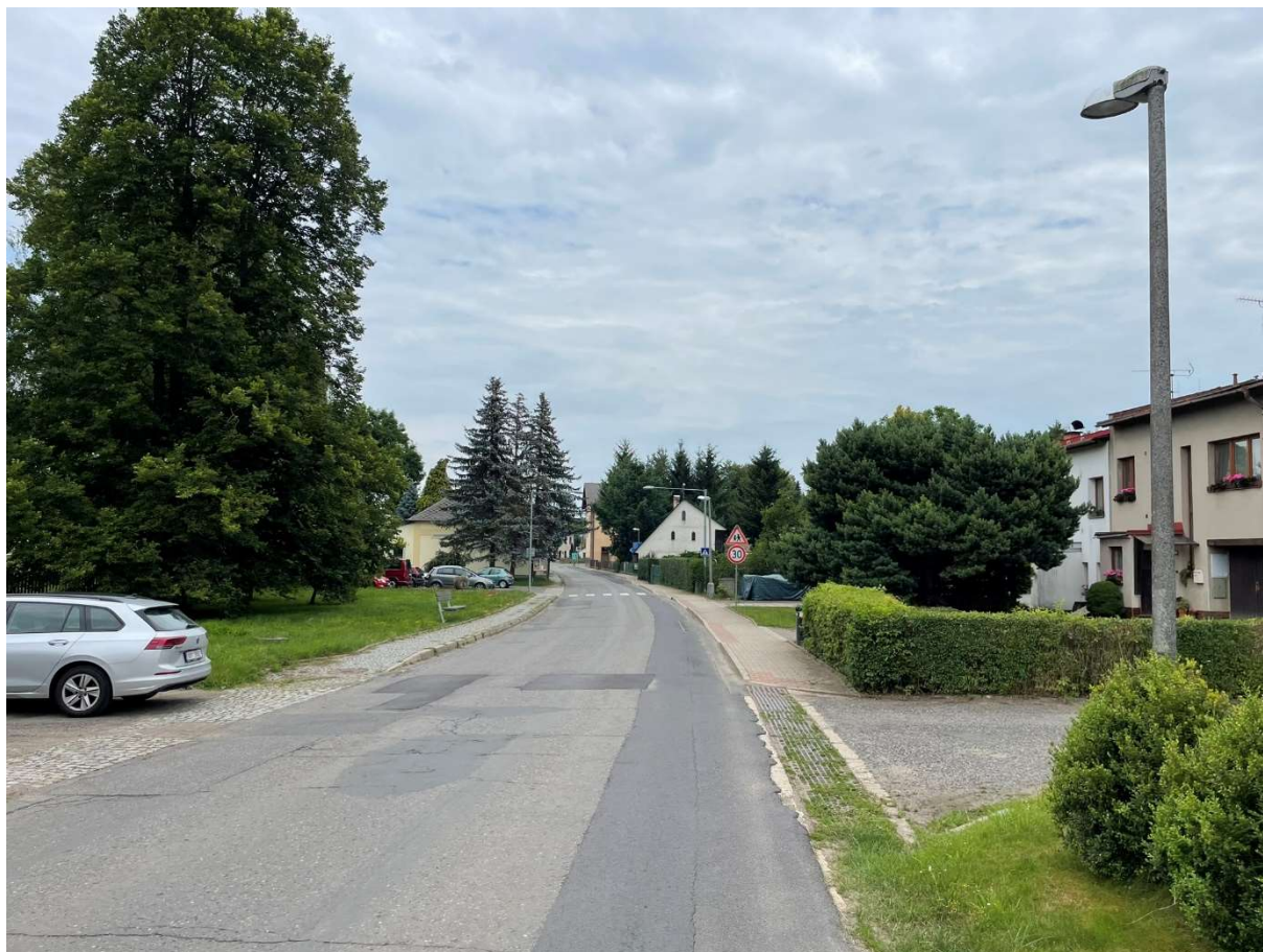
Obr.č.2 – Místo začátku novostavby chodníku u III/2799 – napojení na stávající chodník k centru obce
