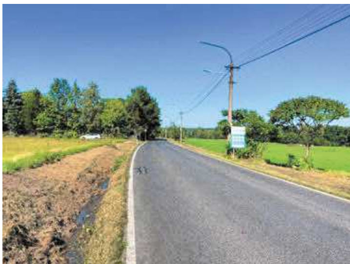
Pohled od stožáru na měřený úsek
