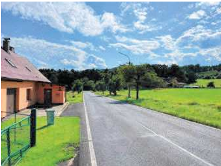
Pohled od stožáru na měřený úsek
