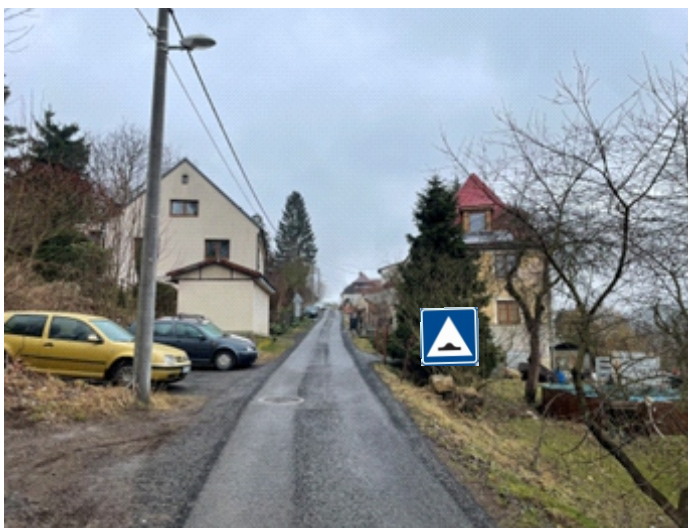
pohled ve směru od železničního přejezdu
